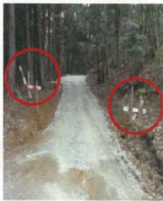
施工の目印となる丁張りの設置
